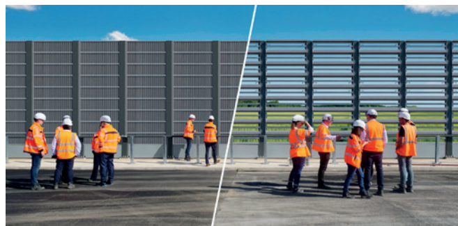
Bild 2: Visueller Vergleich MetaWindow vs. konventioneller Schallschutz
